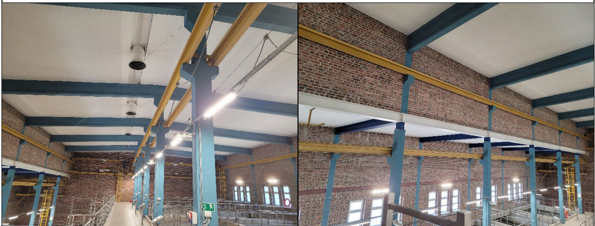
stropodach widoczny od dołu
