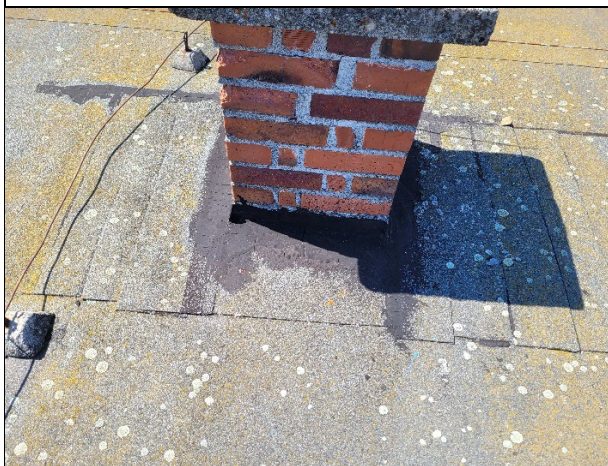
spękania i uszkodzenia pokrycia z papy
