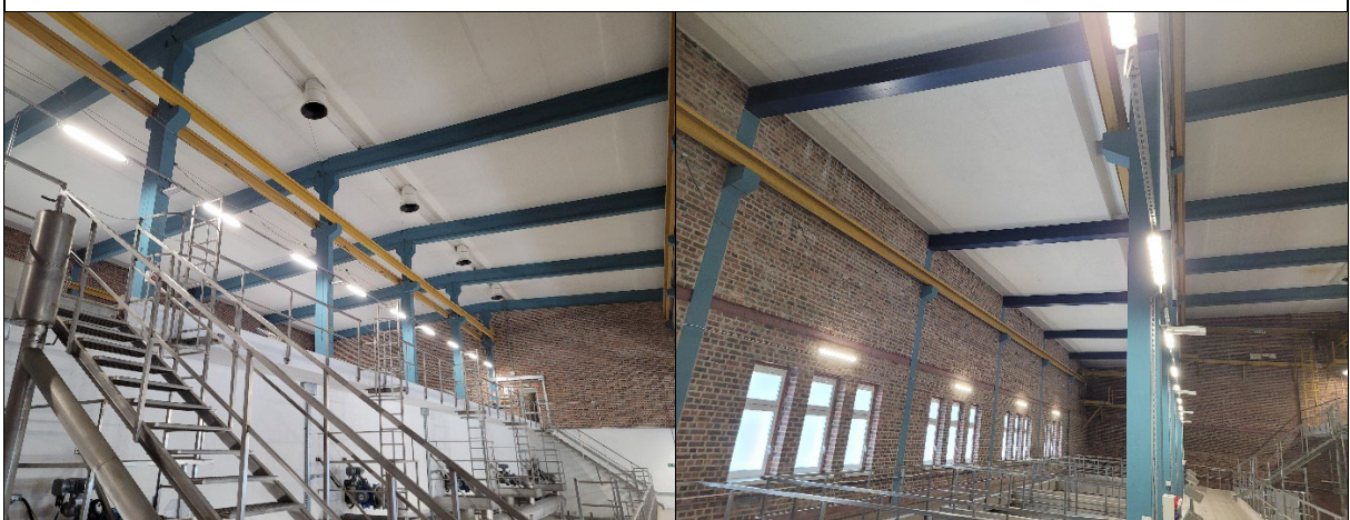
stropodach widoczny od dołu
